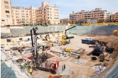
Intercambiador de calor con el subsuelo (sondas en perforaciones)
