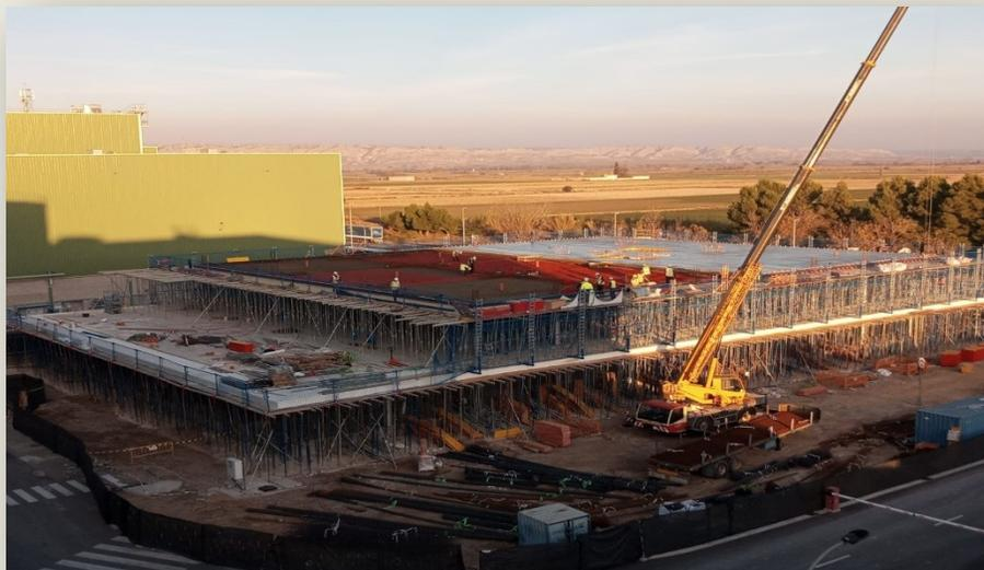
Edificio GEOTABS de 6.000 m<sup>2</sup>. La unión de un sistema geotérmico GEO con un sistema de forjado termoactivo TABS se convierte en una de las soluciones renovables más eficientes, sostenibles y comprometidas con el medioambiente del mercado.
