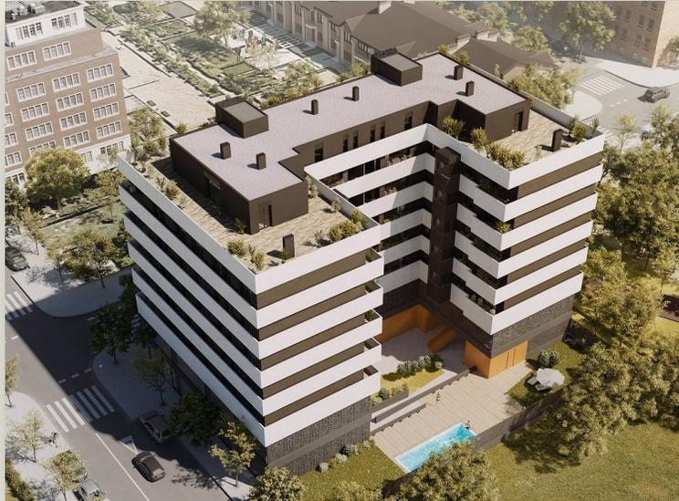
Cuenta con la mayor eficiencia energética con un único sistema de producción geotérmico. Con 20 perforaciones de 145 metros cada una, se abastece calefacción, refrigeración y agua caliente sanitaria.
