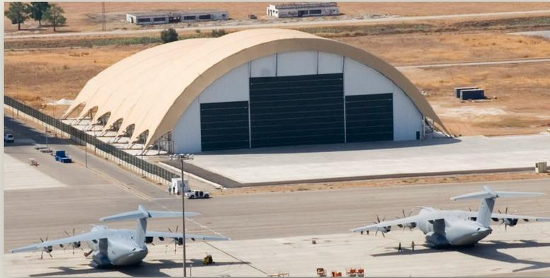
Hangar de 6.000 m<sup>2</sup> para Airbus A400M en Sevilla. Ejecutado con un sistema de edificación rápida en arquitectura modular y alta eficiencia energética.
