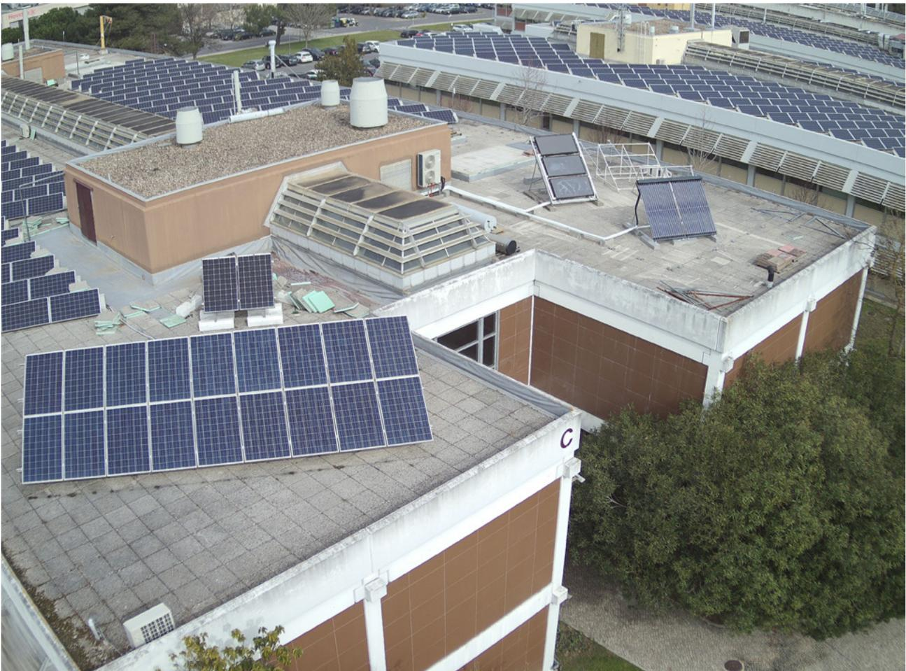
La planta piloto está alimentada por un sistema fotovoltaico de 4 kWp y un aerogenerador de 2,5 kW y un sistema de almacenamiento de baterías de 30 kWh, todo ello integrado en un sistema de trigeneración solar que proporciona electricidad para alimentar una microrred. La energía de confort térmico es proporcionada por una instalación de Agua Caliente Sanitaria (ACS) de colectores solares de tubos de vacío de 4m<sup>2</sup>
